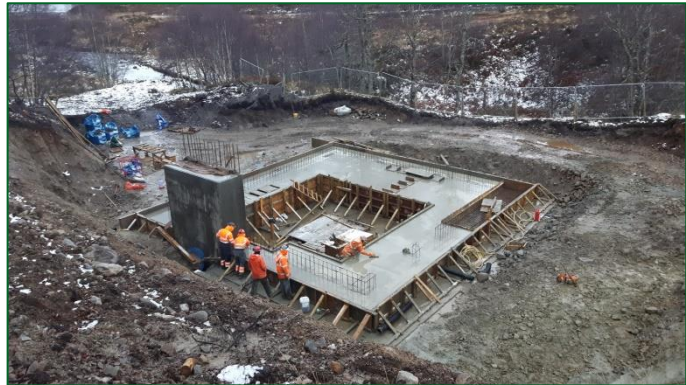
Abhainn Gleann nam Fiadh powerhouse substructure
